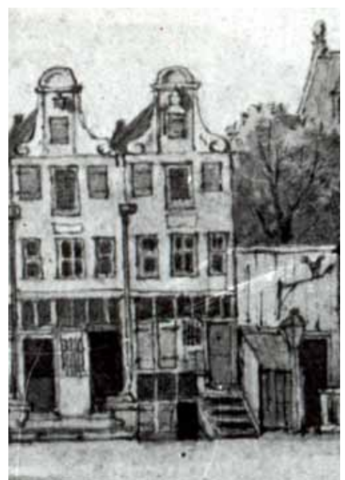
21 Detail van tekening van G. Lamberts, 1816 (afb. 9), met het 17de-eeuwse pand met souterain waarin de waterput was gesitueerd
