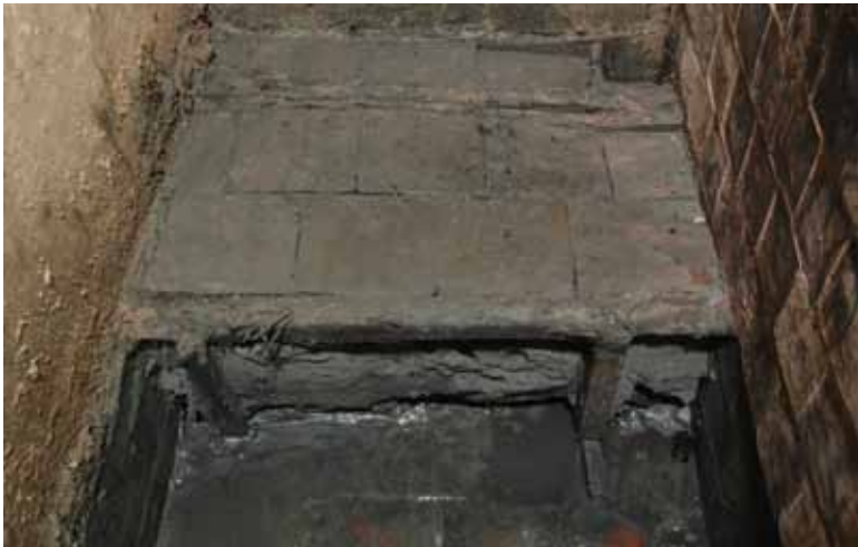
26 Zuidoostelijk bassin van het mikwe, gezien richting zuidwesten, na gedeeltelijke verwijdering van de badvloer. Op de onderste vloer staan houten paaltjes die de dwarsbalken dragen. Tussen deze vloer en de badvloer ligt een pakket van schoon grijs zand. In de rechter bovenhoek bevindt zich het afvoergat
