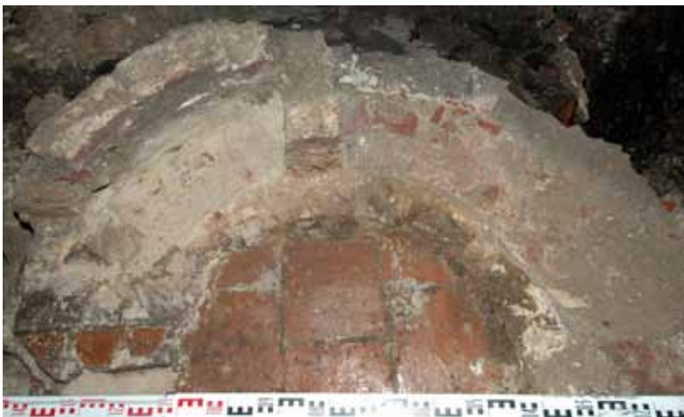
28 Het halfronde restant van de ovenwand
