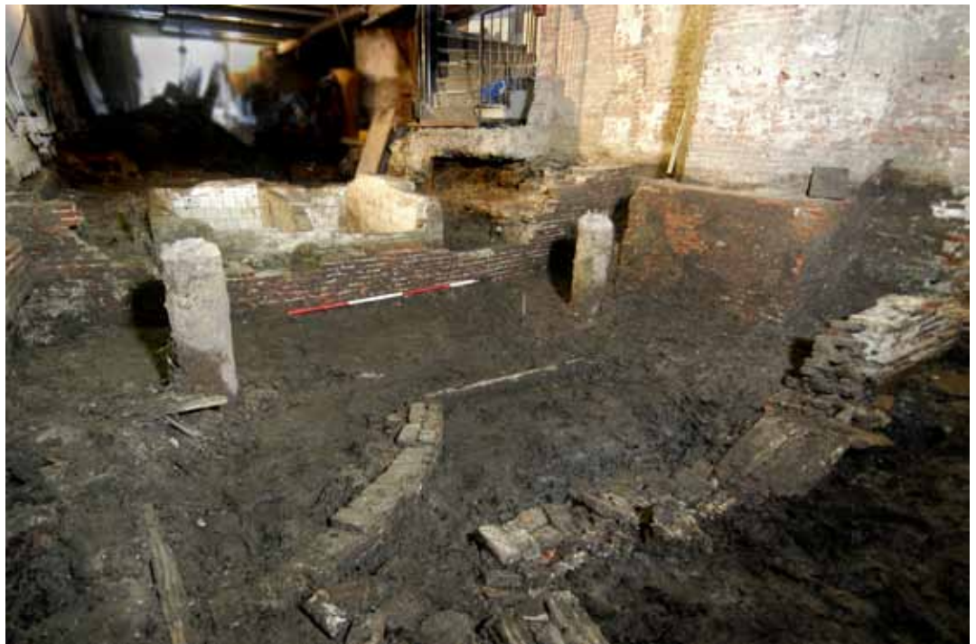
19 Overzicht van het vlak in het westelijk deel van ruimte C, gezien naar het oosten richting straat. Op de voorgrond de deels gesloopte, deels verzakte muur S 46, daarachter de rand van een uitgebroken (water)put. Op de achtergrond ligt het midden-18de-eeuwse mikwe
